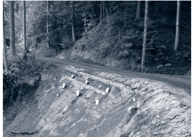
Einbau von Holzkästen in der Bilchen
