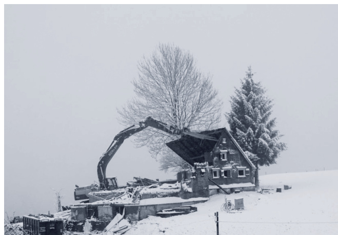
Abbildung 3: Abbrucharbeiten Wohnhaus Schönenbüel 674
