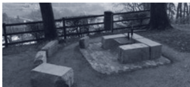
Neugestalteter Rastplatz Schlipf
