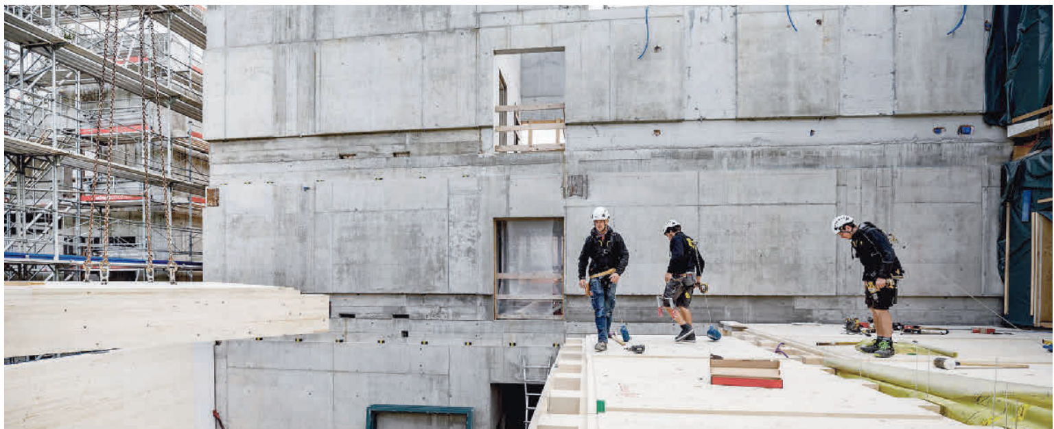
Arbeiten beim Neubau Sekundarschulhaus ↑
