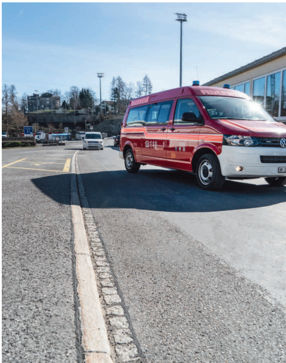
↑ Beschlossene Sanierung Landhausstrasse»
