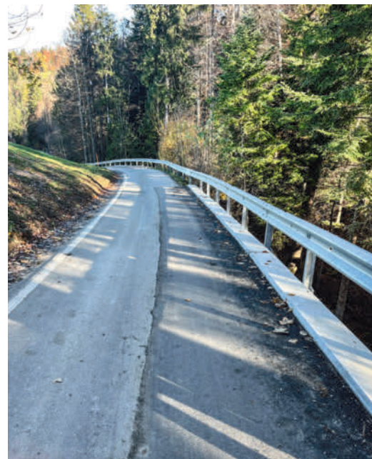
Belagssanierung Alte Speicherstrasse ↓
