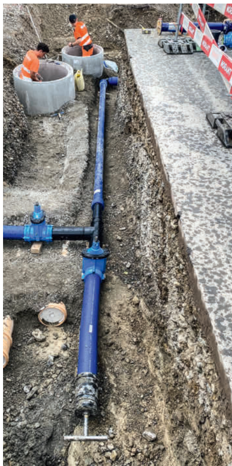
↑ Leitungssanierung Steinerstrasse
