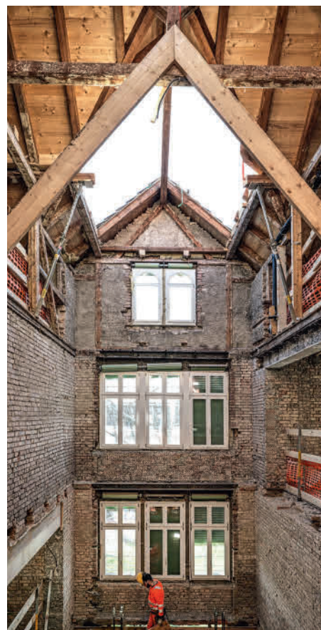
Schulhaus «altes Hörli» in der Kernsaniierung ↑
